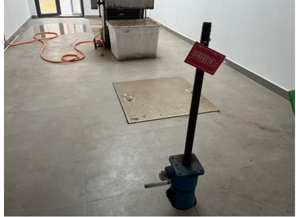
污水处理站事故应急池切换阀门
