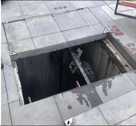
污水处理站事故应急池
